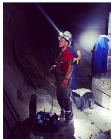
*Рис. 3 Визуальное обследование состояния горной выработки калийного рудника сотрудниками лаборатории*
